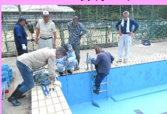
プール塗装(シルバー人材センター)
